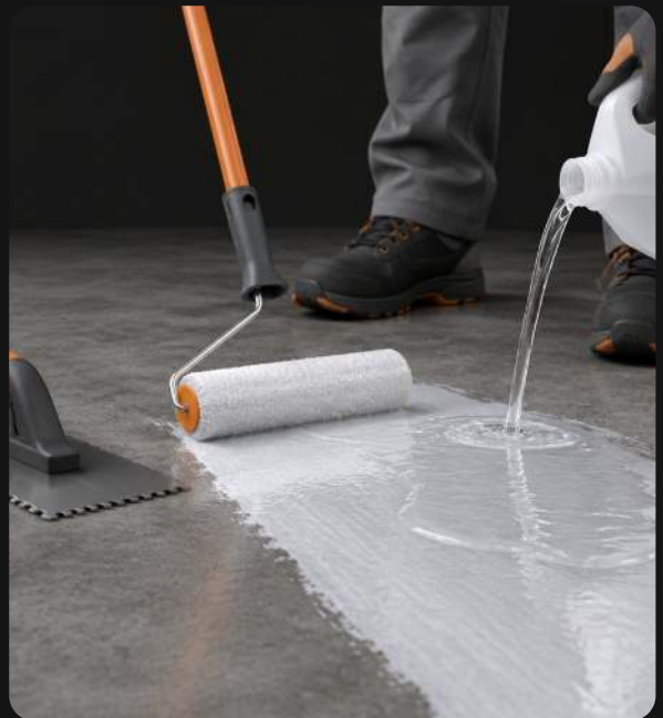
Imprimación con rodillo y baño de alcohol
