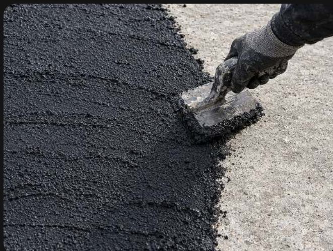
Con llana metálica
