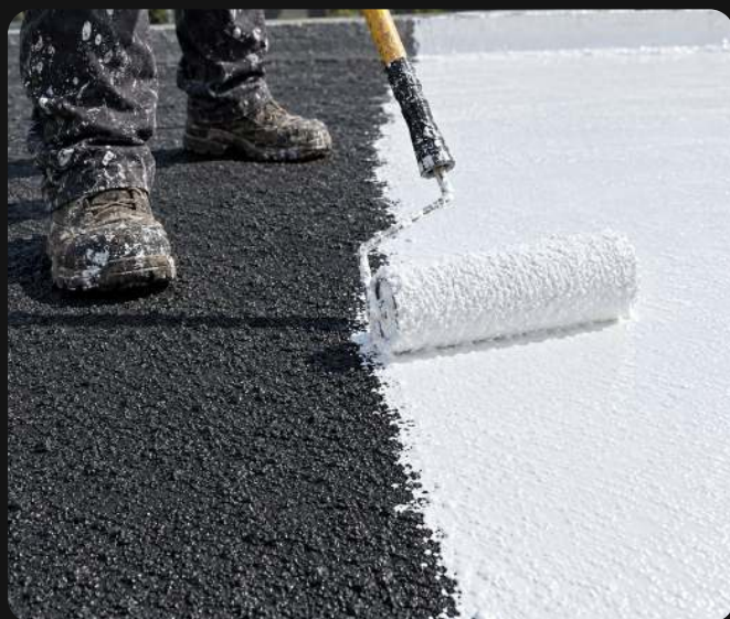
Sobre la Membrana de Caucho
