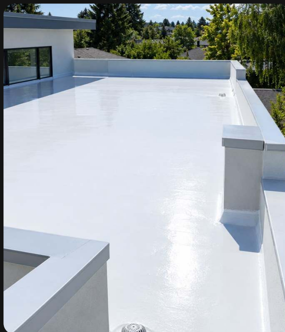
Techo terminado en blanco
