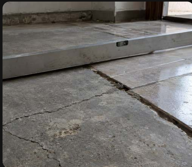
Piso a recuperar
